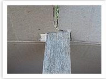
Colocamos el travesaño.
